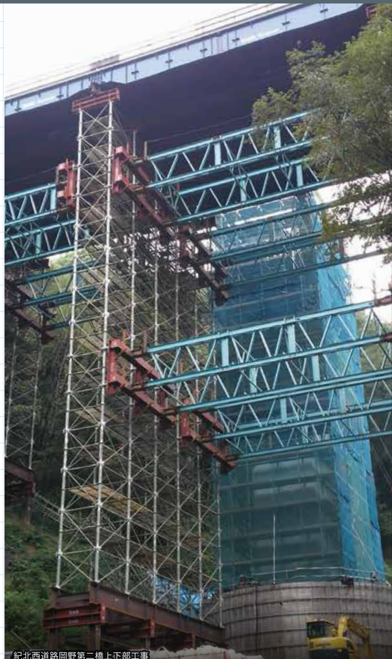
紀北西道路岡野第二橋上下部工事
