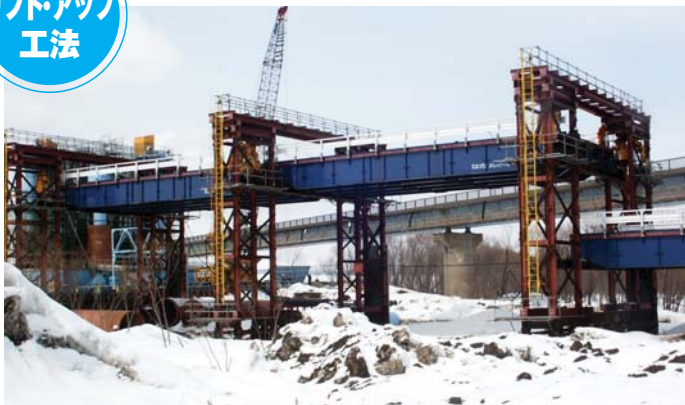
◀ 北海道 道道江部乙雨電線江竜橋架換(下部工)工事
