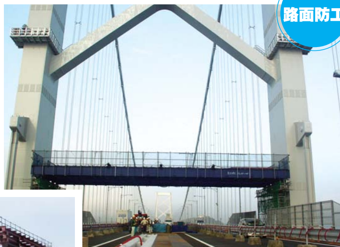
▲ 徳島県 / 大鳴門橋路面防護工 / P3主塔
