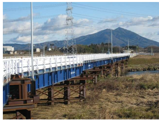
プレガーダー®橋架設事例（茨城県）
