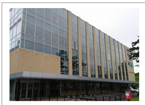
▲北広島市役所 新庁舎
